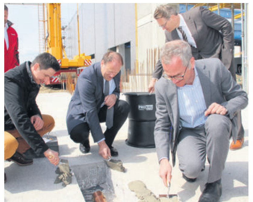
Während der Grundsteinlegung wurde eine Zeitkapsel in die Aussparung der Bodenplatte des neuen Kompetenzzentrums in Bisingen gelegt.
